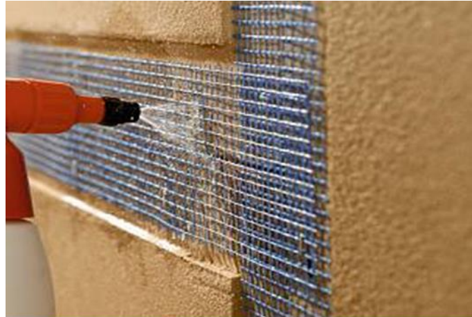
Lehm reguliert die Luftfeuchtigkeit (Quelle: epr/BKM Mannesmann)
