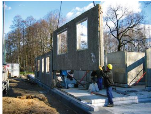
Wiederverwendung von Plattenbauteilen (Quelle: DBU/BTU Cottbus)
