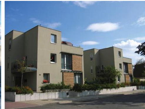
Wiederverwendung von Plattenbauteilen (Quelle: DBU/BTU Cottbus)
