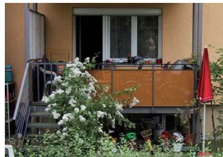
Stufen als Hindernisse
